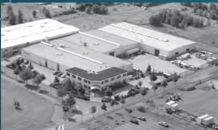
BOSECKER VERTEILERBAU SACHSEN GMBH, ZITTAU
